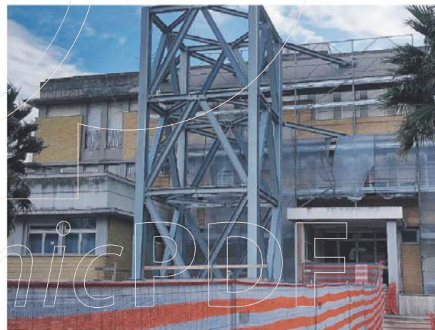
LAVORI IN CORSO Il cantiere del plesso Maternità, al primo piano c'è la Ginecologia
