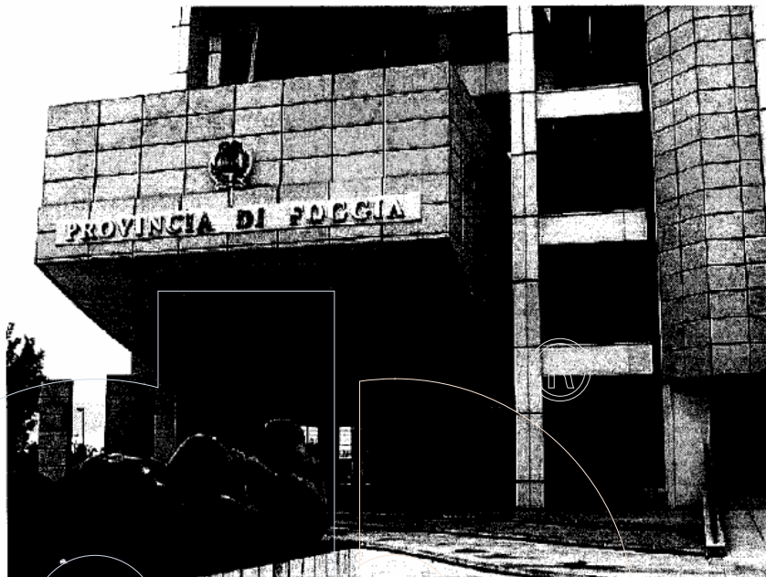
PROVINCIA DI FOGGIA La sede amministrativa in via Telesforo
