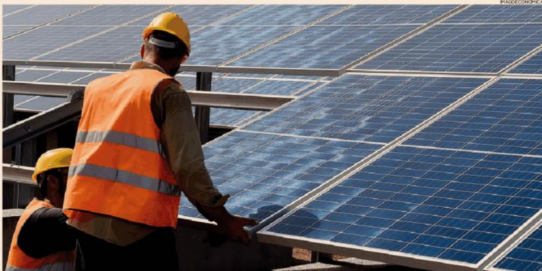
Bonus green. Operai posano pannelli solari. Il nuovo bonus potenziato privilegerà le ristrutturazioni green
