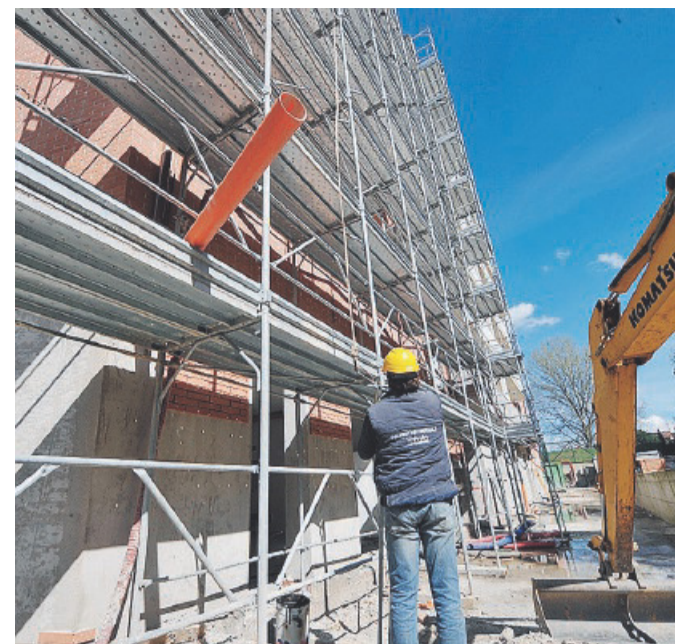
AMPLIAMENTI E RIQUALIFICAZIONI Riparte il Piano casa regionale
