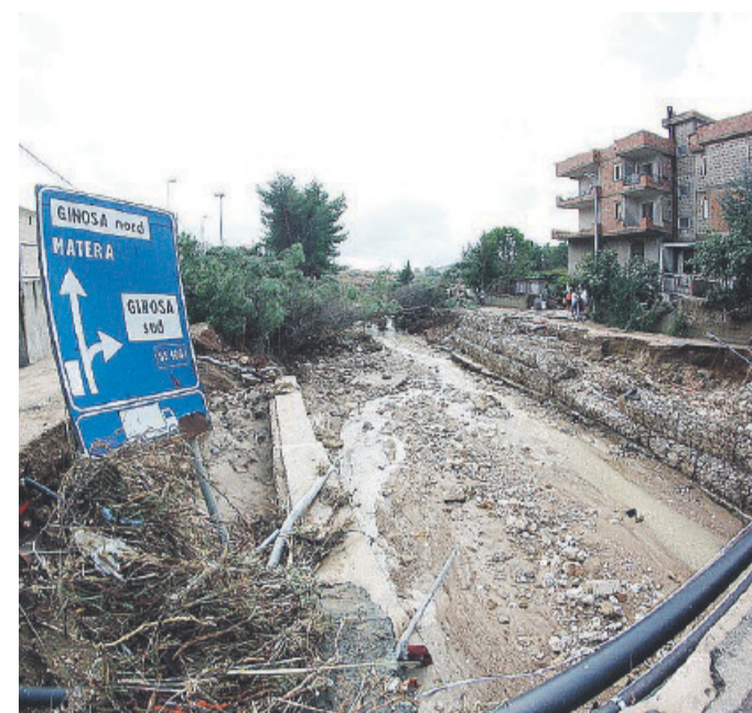
I DANNI DELL'ACQUA L'alluvione che ha colpito Ginosca nel 2013
