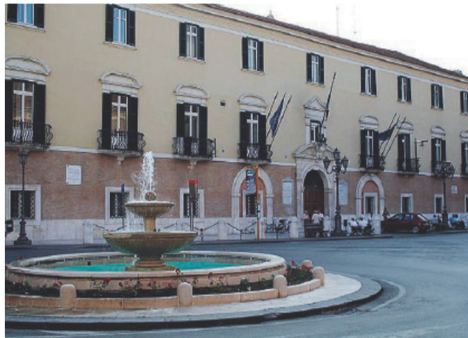
FOGGIA Palazzo Dogana, sede della Provincia
