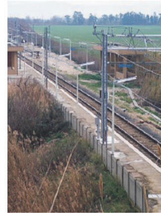
STORICO Il binario risale al 1863
