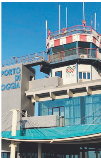
AEROPORTO Lavori alla pista conclusi
