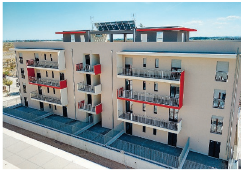
Umno degli ultimi edifici realizzati dall'Arca Capitanata (ex Istituto autonomo case popolari) al quartiere Ortona sud di Foggia
