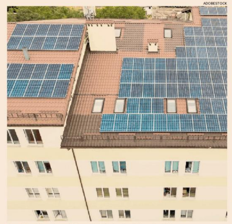
Energia solare. Pannelli fotovoltaici sul tetto dei condomini
