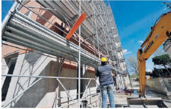
COSTRUZIONI Un cantiere [foto d'archivio]
