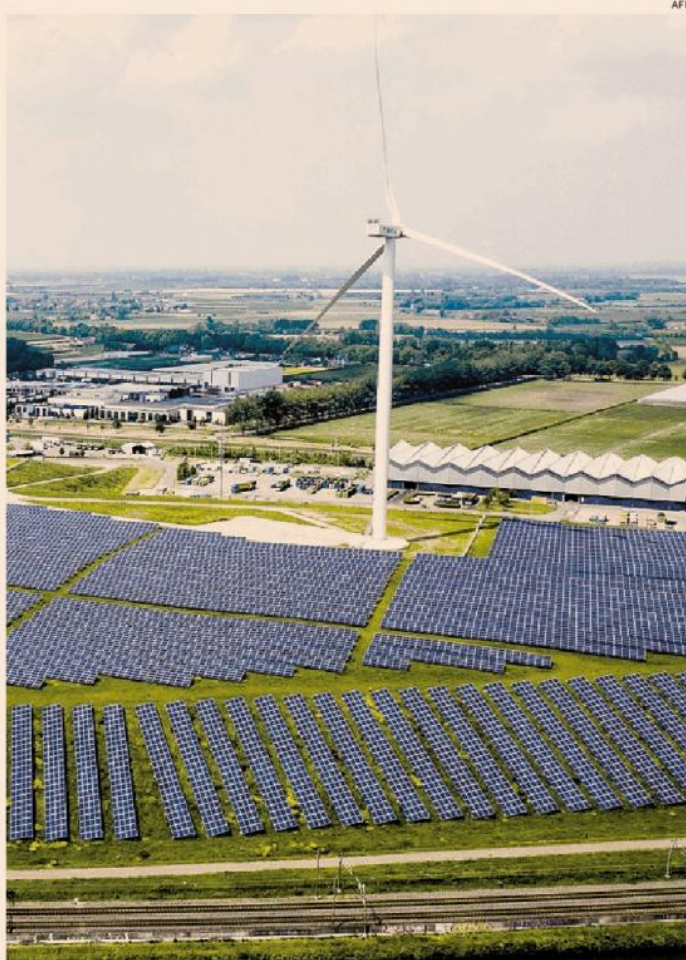
Rinnovabili. I nuovi impianti verdi al centro degli interventi
