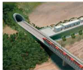
Imbocco di una galleria
