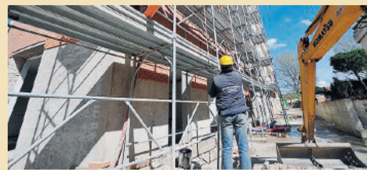
PUGLIA Operai al lavoro in un cantiere
