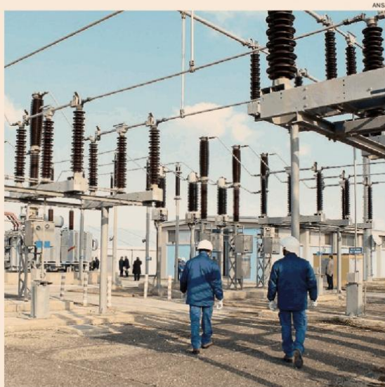
Infrastrutture energetiche. Addetti Enel al lavoro in una centrale
