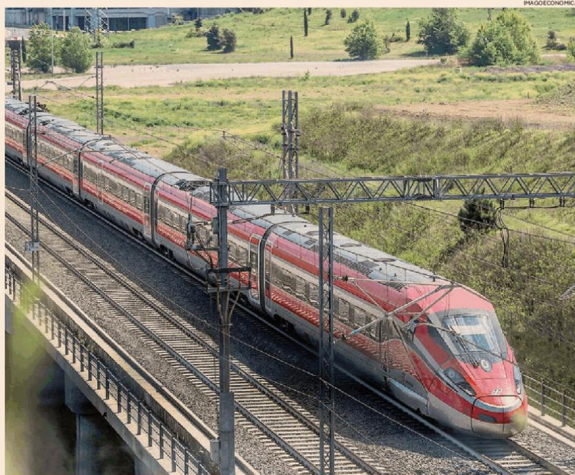
Round finale. Si punta a chiudere la partita dei nuovi corridoi infrastrutturali europei in Italia
