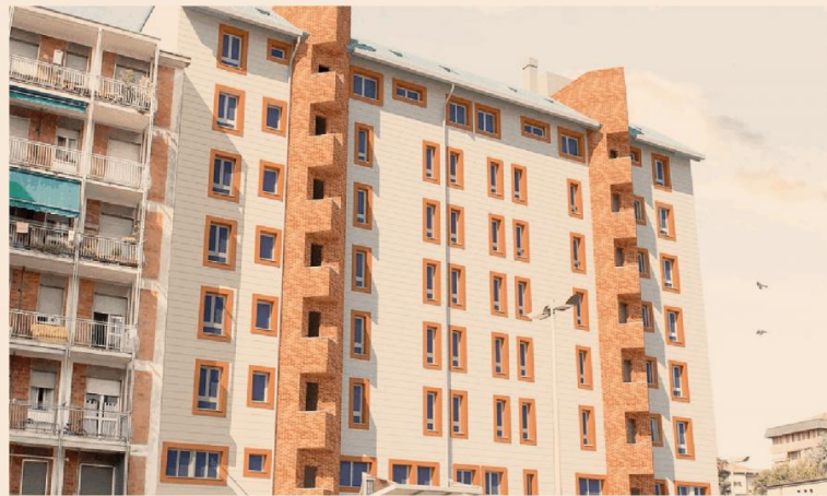
Oltre gli standard. A Cinisello Balsamo un edificio residenziale del 1962 (32 appartamenti, di proprietà della Cooperativa Uniabit) è stato identificato da ZH (spin-off del Politecnico di Milano) come caso studio per un innovativo intervento di riqualificazione con il 110%. In progetto: isolamento, sostituzione in fissi, sostituzione della caldaia, installazione di un impianto fotovoltaico (integrato) da circa 15 kWp, sistema di termoregolazione smart e creazione di una comunità energetica locale per l'autoconsumo dell'energia prodotta. Il fabbisogno energetico sarà ridotto di circa il 70%, con un risparmio atteso di 500 euro all'anno per unità immobiliare (Maria Chiara Voci)
