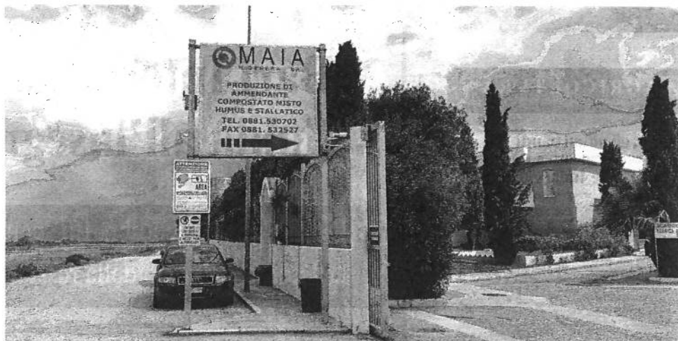
La centrale di contrada Ripatetta
