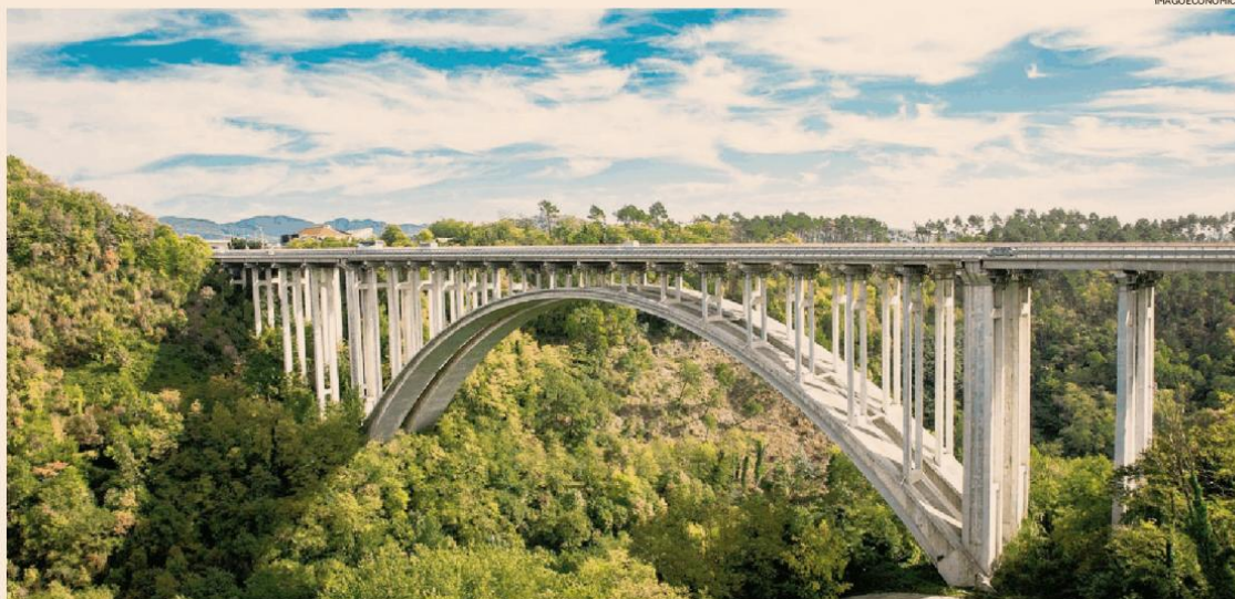
Digitale e tecnologie. L'alleanza fra Fincantieri, Almviva e Leonardo per il monitoraggio delle grandi infrastrutture critiche
