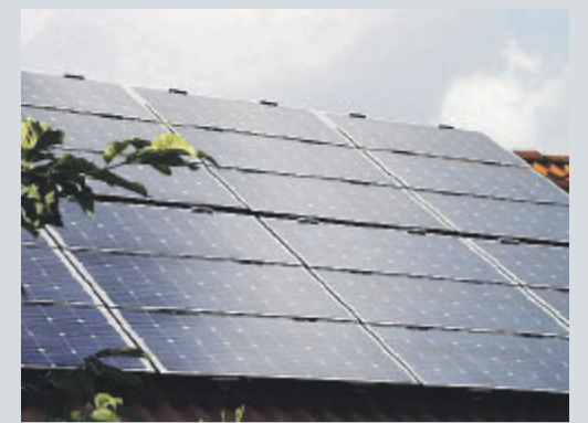
ENERGIA VERDE Pannelli solari su un tetto
