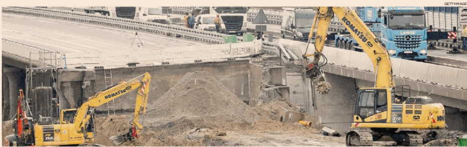
Paracadute antirincari. Per il 2022 lo scudo vale anche per i lavori dei general contractor delle opere in corso del gruppo Fs e Anas
