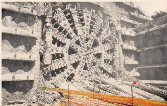
Autostrade/1. Nella foto sopra: ingegnere Tecne (Aspi) al lavoro in un cantiere lungo la rete; a sinistra: la fresa Tbm in azione. La nuova galleria Santa Lucia (A1) è stata scavata con l'ausilio della fresa Tbm più grande d'Europa
