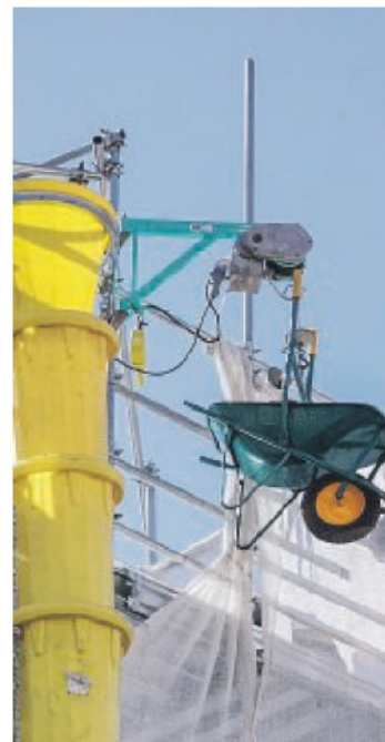
SUPERBONUS Un cantiere
