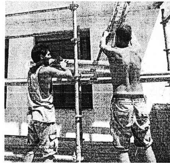
SENZA PROTEZIONE Due operai in un cantiere edile
