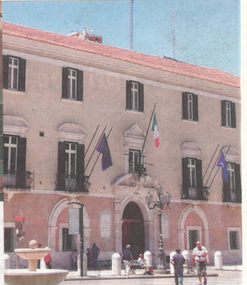
Il sito dell'intervento e Palazzo Dogana
