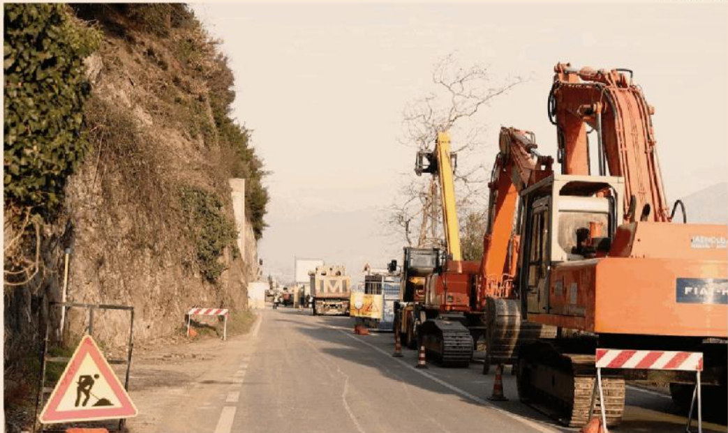
Cantieri. Da aprile la prima finestra utile per l'accesso al fondo contro il caro energia e il caro materiali
