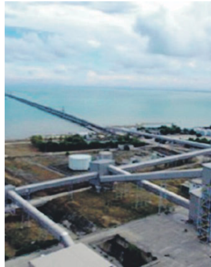
PORTO INDUSTRIALE L'area Asi di Macchia-Monte Sant'Angelo
