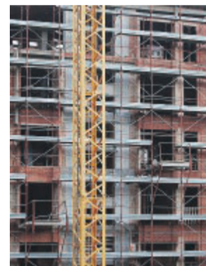
Un cantiere edilizio
