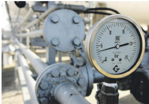
FORNITURE Il terminale di una condotta
