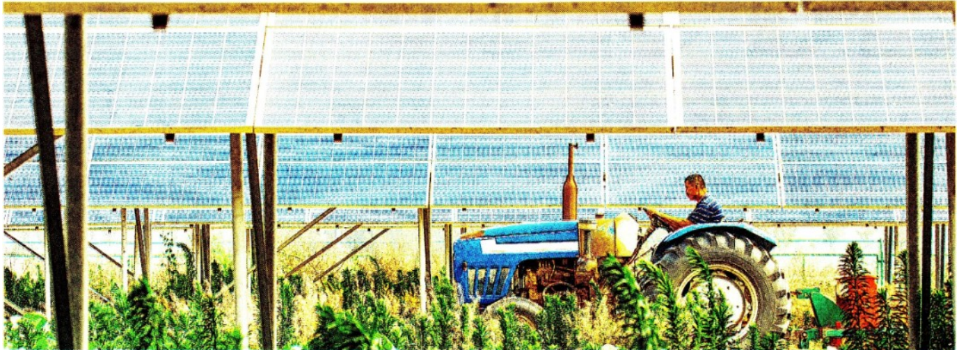
Pannelli sospesi. Lagrivoltaico è l'energia rinnovabile "preferita dagli agricoltori" perché, a differenza del fotovoltaico tradizionale, non prevede il consumo di suolo
