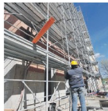
CANTIERE Un operaio al lavoro tra le impalcature
