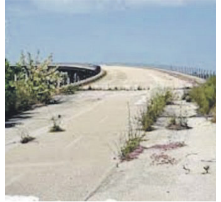
Iniziata e mai completata: riprendono i lavori
