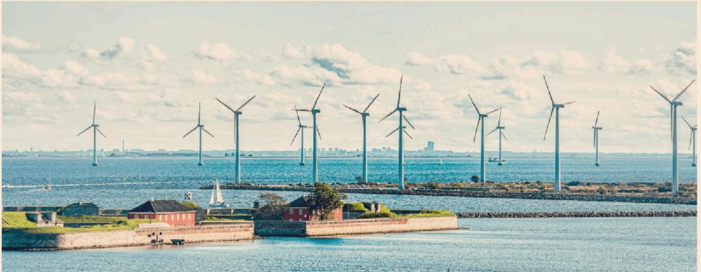
Vento. Secondo l'ultima rilevazione di Terna, ad agosto l'eolico ha coperto il 15,5% della produzione da rinnovabili
