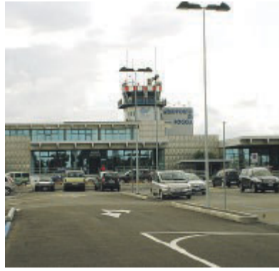
GINO LISA Lo scalo foggiano costruito negli anni Settanta
