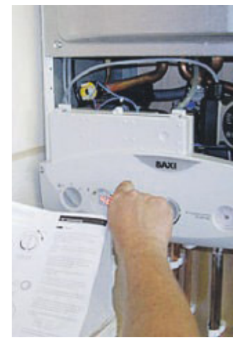
Verifica impianti termici
