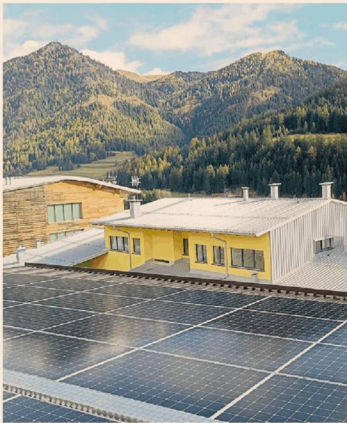
Val di Fassa. La prima cer della valle, sul tetto della scuola a Pozza di Fassa (Trento)
