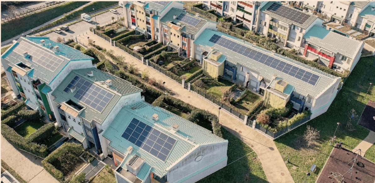
Comunità energetiche. Una comunità energetica consiste in un'associazione tra cittadini, attività commerciali, pubbliche amministrazioni locali e piccole/medie imprese che decidono di unire le proprie forze con l'obiettivo di produrre, scambiare e consumare energia da fonti rinnovabili su scala locale. In questo modo si intende creare una rete decentralizzata in cui è richiesta la partecipazione consapevole di ogni cittadino
