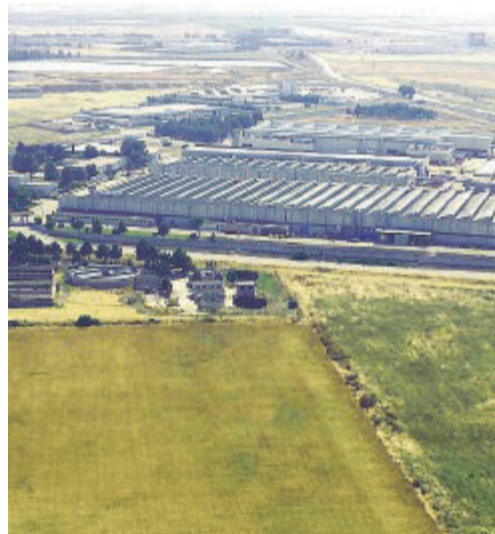
Il tratto della 16 serve anche l'area industriale
