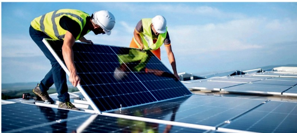
▲ Il business Il montaggio di un impianto di pannelli fotovoltaici
