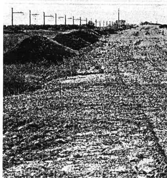
FOGGIA I lavori fermi nei pressi di Cervaro
