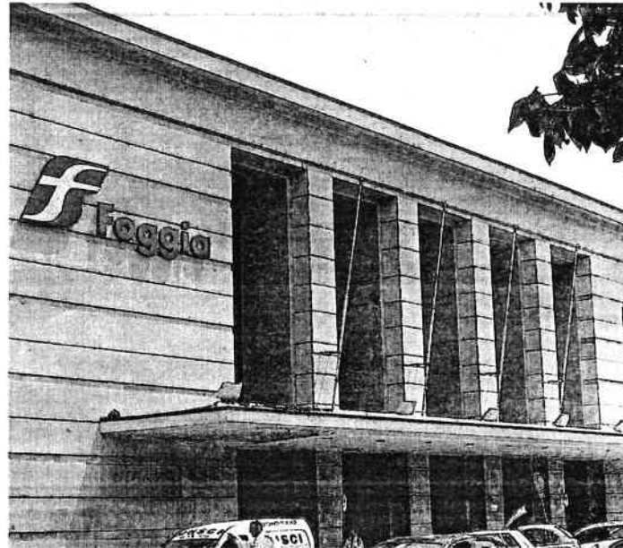
FOGGIA L'ingresso monumentale della stazione ferroviaria di piazza Vittorio Veneto
