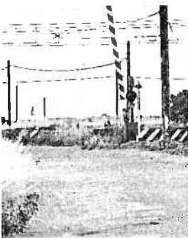
FOGGIA La tratta ferroviaria Foggia-Caserta ed uno dei passaggi a livello
