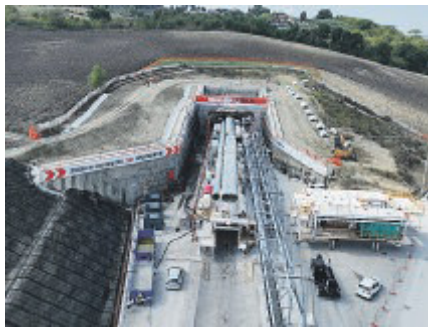
DALL'ALTO Il cantiere di Grottaminarda
