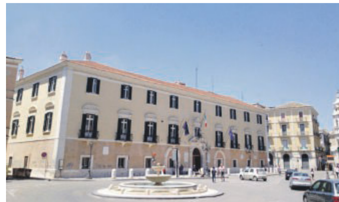
FOGGIA Palazzo Dogana, sede della Provincia
