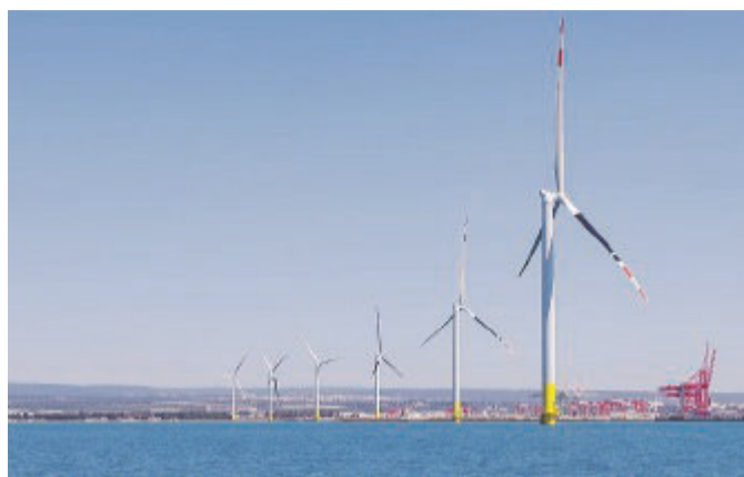
ENERGIA Un impianto eolico off shore
