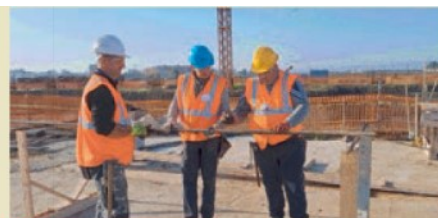
Operai al lavoro
