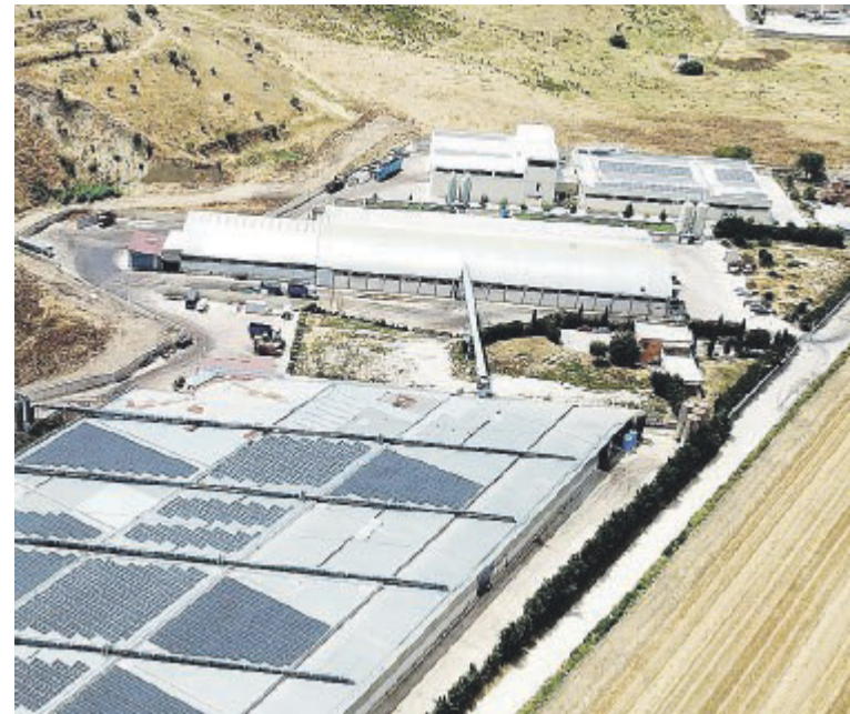
Uno degli impianti esistenti di Maia Rigenera a Lucera
