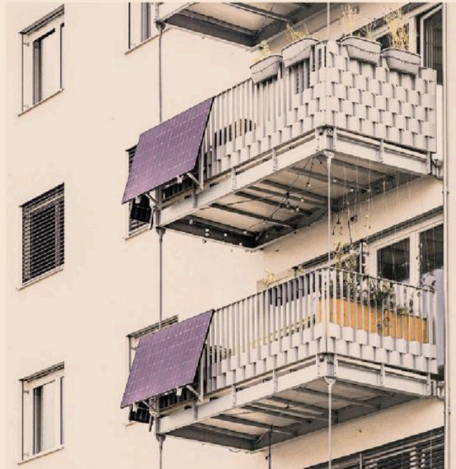
L'installazione. Possibile minimizzare l'impatto dei pannelli
