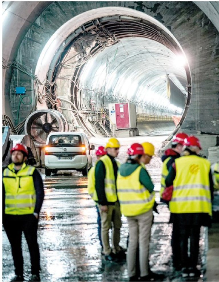
In difficoltà. Per problemi geologici il progetto del Terzo valico dei Giovi è in ritardo
