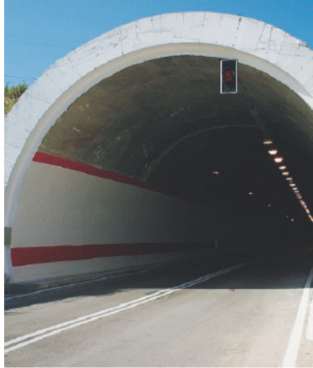
Lavori in corso nella galleria
