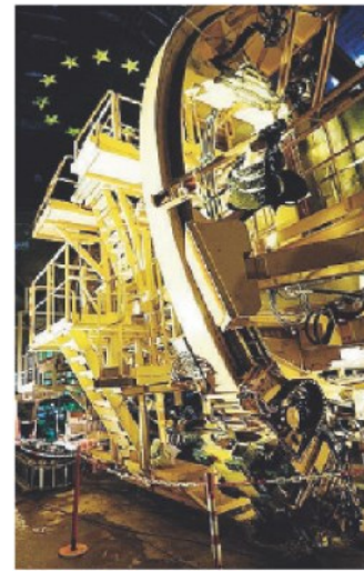
TAV Parte del cantiere
