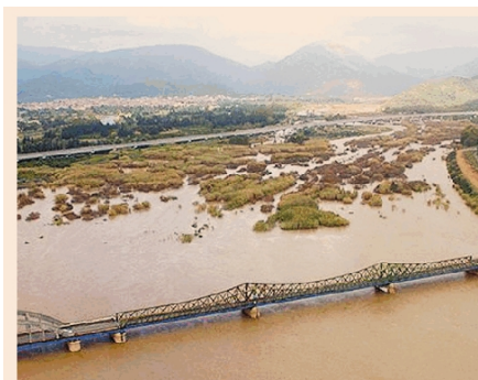
Sotto osservazione in Sardegna Il ponte sul Flumendosa, situato a Villaputzu
