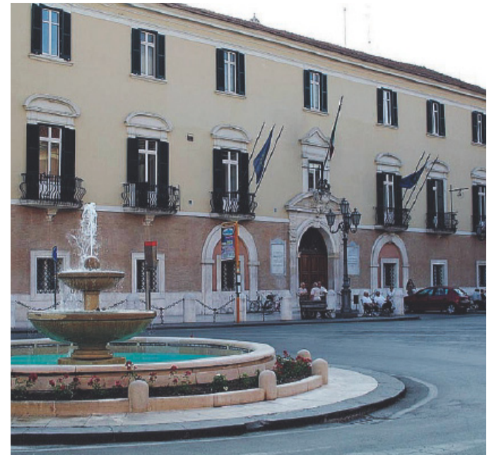
FOGGIA Palazzo della Provincia
